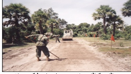
فحص التربة التي يتم جمعها بواسطة مغراف مركبة التحميل في منطقة البحث، كمبوديا.
