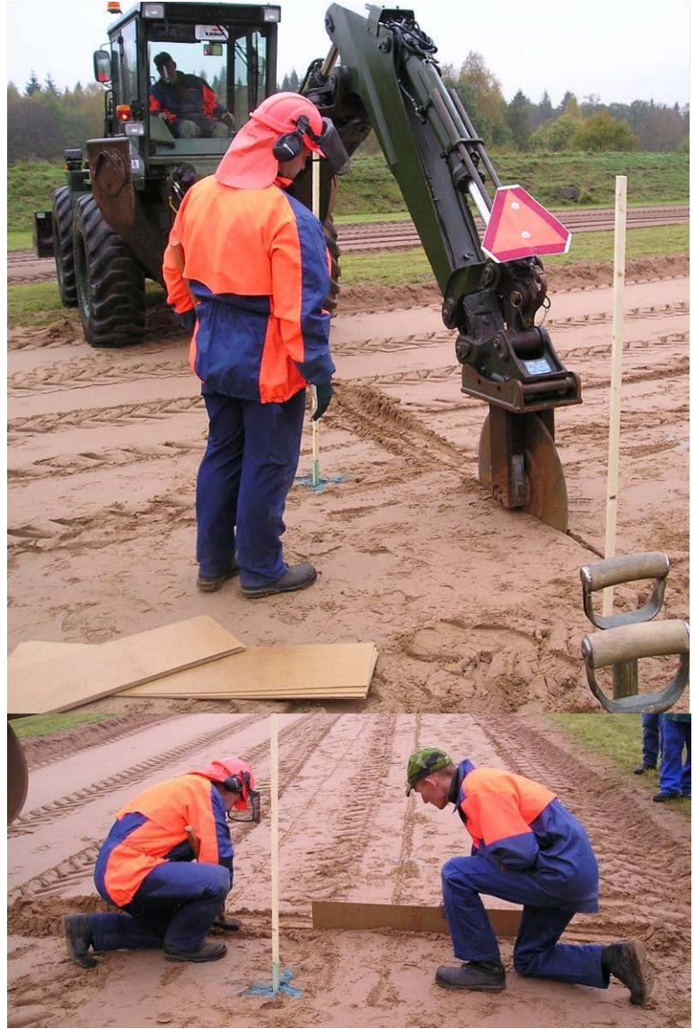
المستند أ.3. - وضع الألواح الليفية بطريقة مناسبة.
