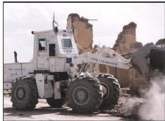
Déblaiement de gravats à l'aide d'une chargeuse blindée, Kaboul, Afghanistan.
