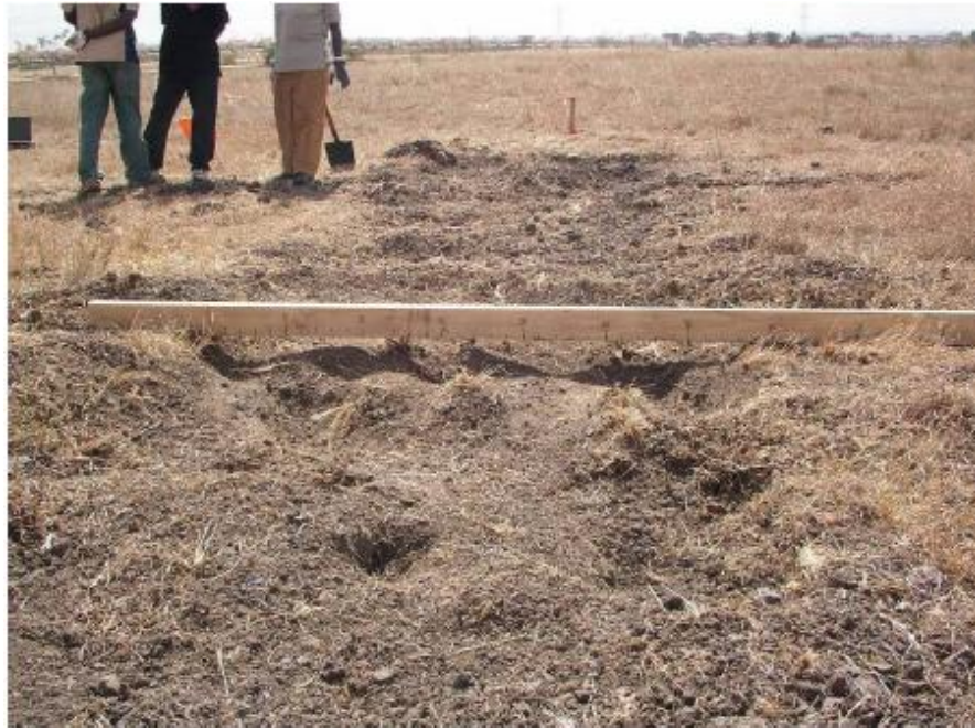
Figure 6 : Faible pénétration du marteau sur une surface dure
