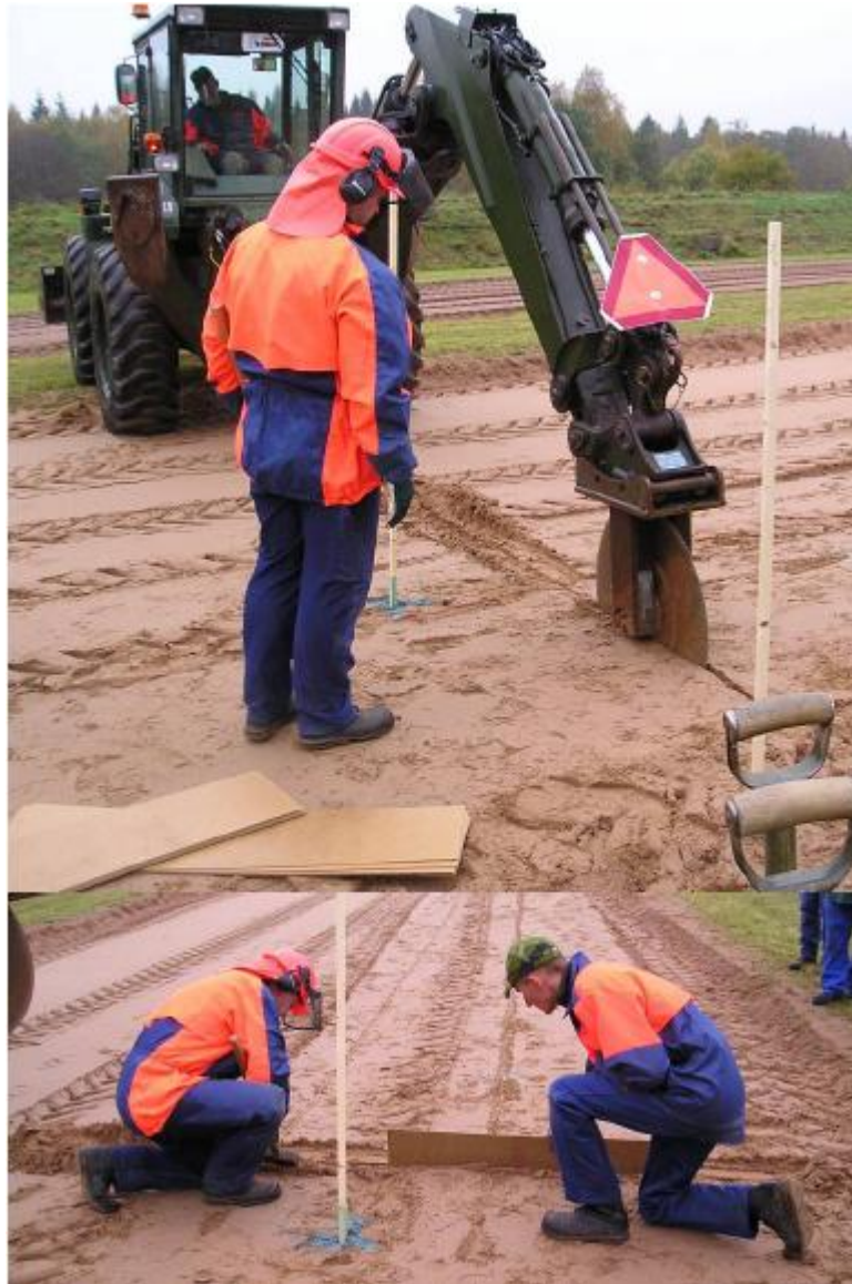
Image 3 : Installation correcte des panneaux de bois aggloméré
