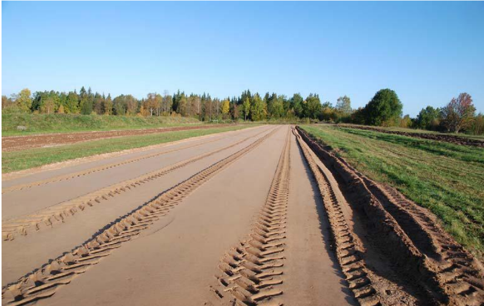
Figure 4 : couloir de test préparé avec le sol compacté image © GICHHD
